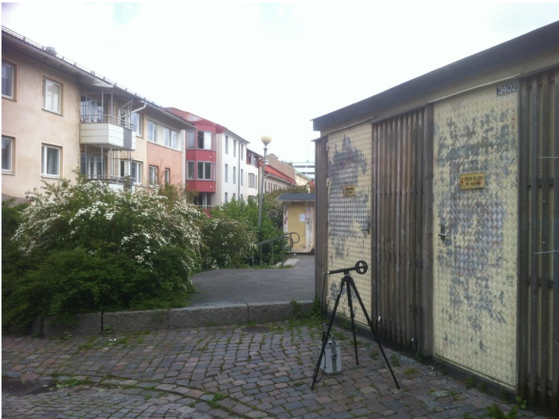
Figur 2. Foto på mätutrustningen vid transformatorstationen på Mellangatan.
