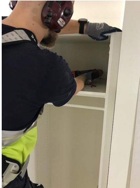
Figur 8. Uppsättning av skåp i bostadsrätt.
