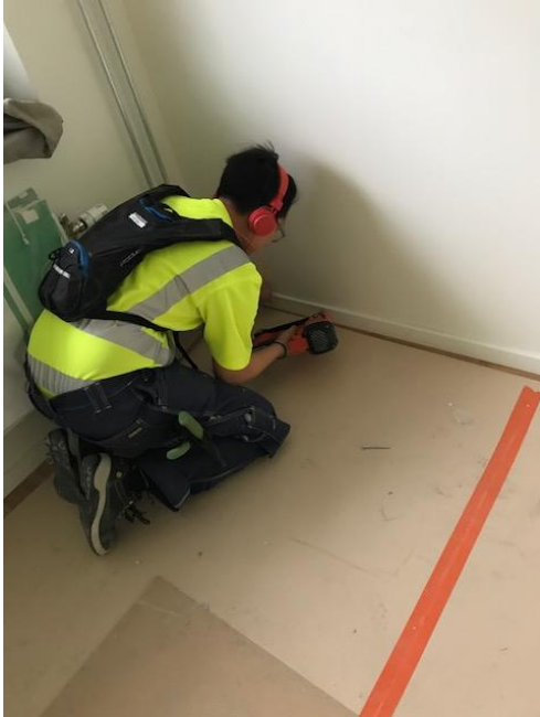
Figur 7. Spikning av trälist i bostadsrätt.
