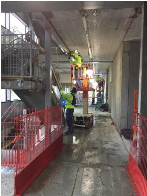
Figur 9. Uppsättning av bleck i betong
