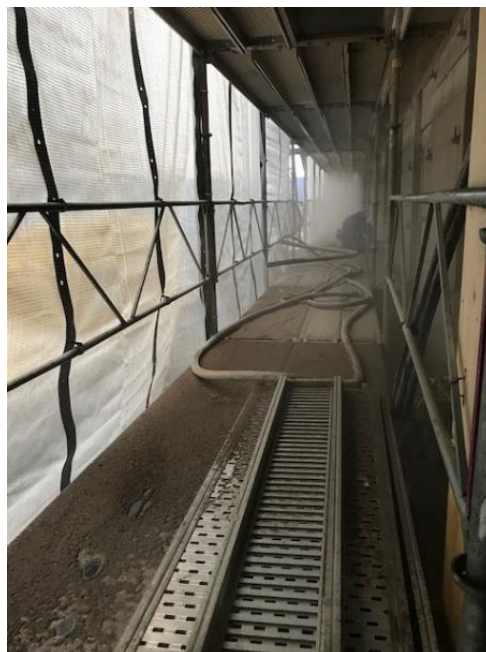
Figur 10. Sandblästring av fasad (utfördes ej av deltagare i studien)
