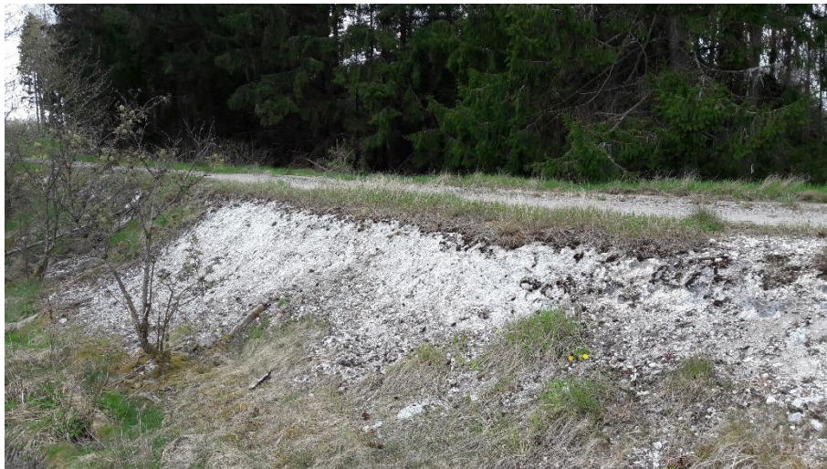
Bild 4. Grusväg med ferrokromslag som fyllnadsmaterial
